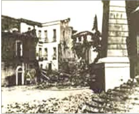
Foggia— Effetti di un bombardamento sulle abitazioni civili nel centro della città.
